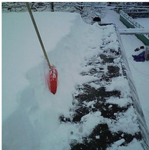
写真 2 屋根の底部分の雪庇除去
